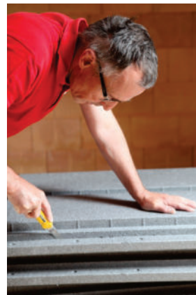
Untersparrendämmung Deckmaß 1250x600mm; 0,75 m 2 Plattenmaß 1290x640mm
